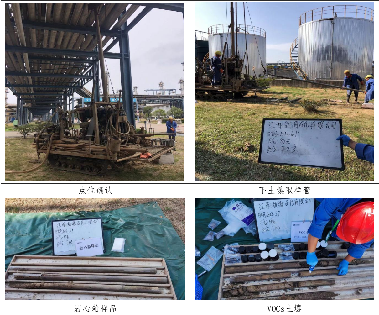
图 3-3 土壤钻孔取样过程演示
